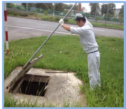
Kiểm tra cống thoát
